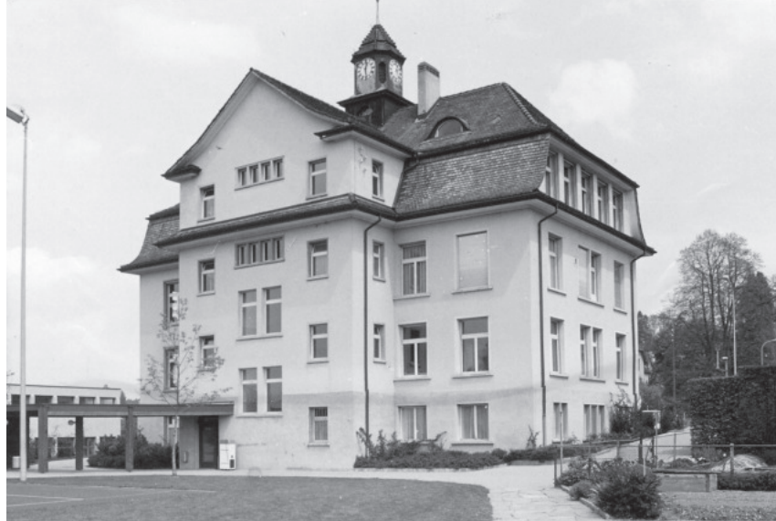
Abbildung 4: denkmalgeschütztes Primarschulhaus erbaut 1898 / 1899
