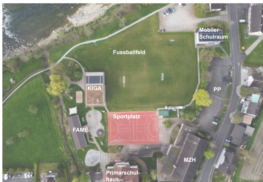
Abbildung 1: Luftaufnahme Schulareal Bestand
